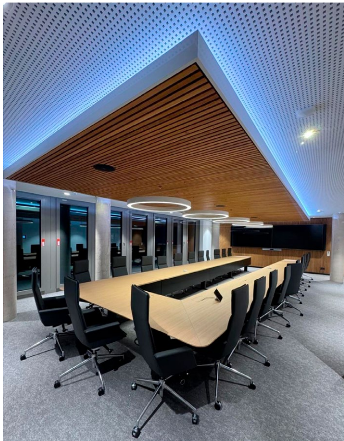
Moderne Deckenlösung – eine Kombination verschiedener Werkstoffe. Die Kombination von Lochgipsdecken und Akustikpaneelen verbessert die Raumakustik deutlich und erfüllt die Anforderungen an zeitgemäße Arbeits- und Kommunikationsumgebungen (Fotos: OKEL GmbH & Co. KG)
