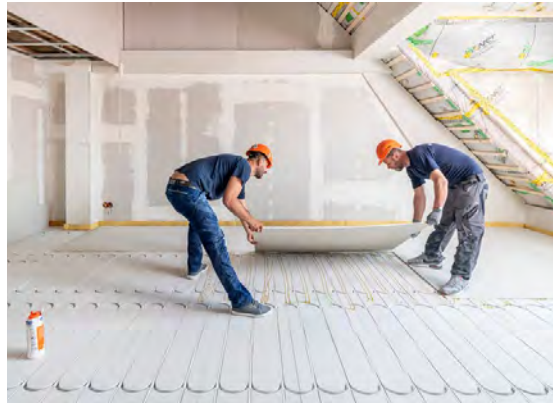
Schlanker Systemaufbau und schon nach 24 Stunden belegreif (Fotos: James Hardie Europe GmbH)
