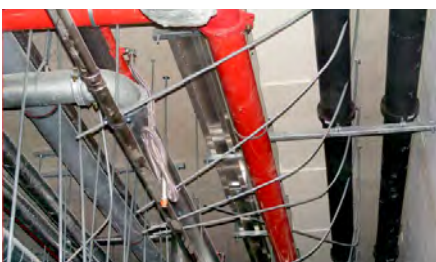
Decken-Abhänger wurden bei Arbeiten nachfolgender Gewerke in Mitleidenschaft gezogen und sind beschädigt und verbogen worden
