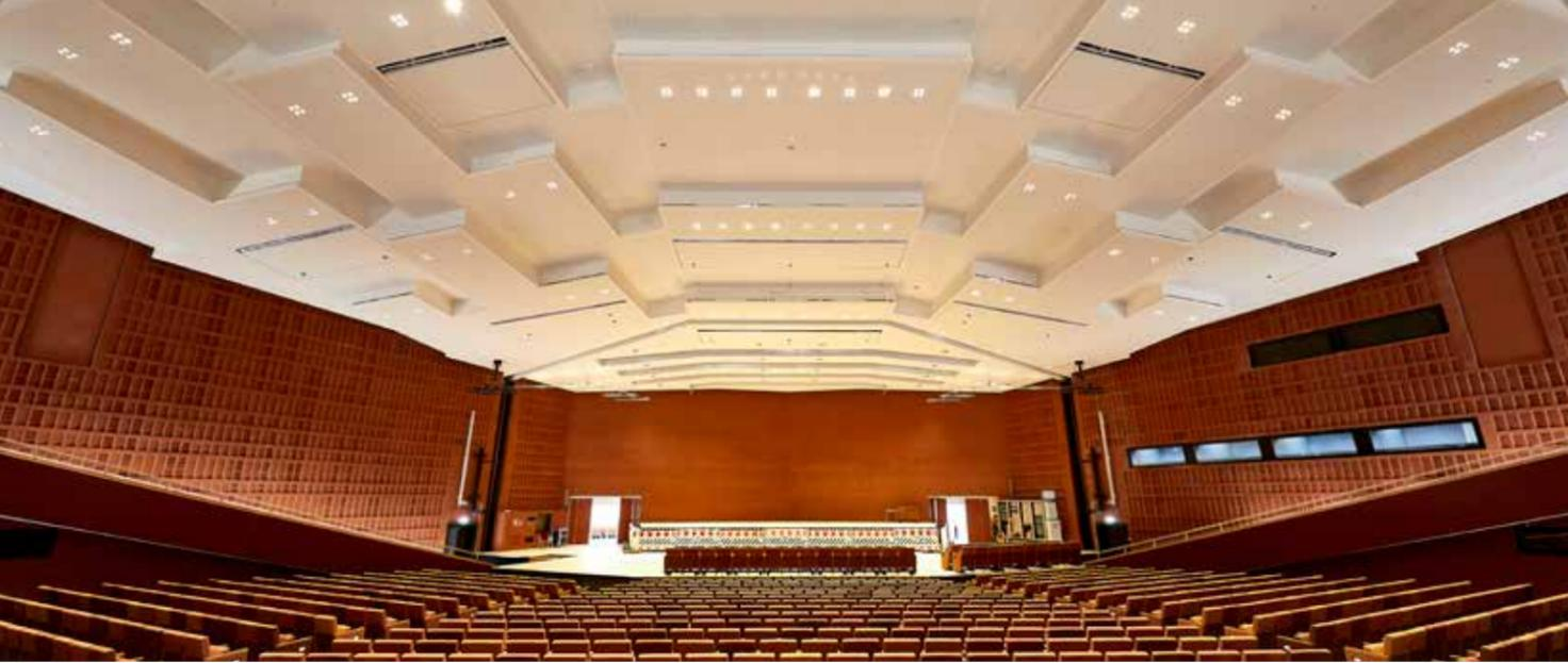
berechnete Unterkonstruktion aus Knauf Stahl-Leichtbauprofilen zum Einsatz. Glatte Balustraden erhielten eine Beplankung mit Knauf Diamant-Hartgipsplatten.
