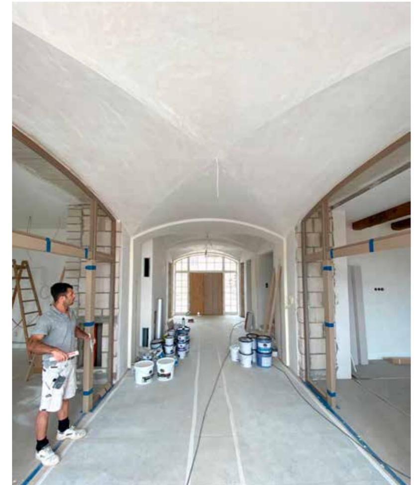
Trockenbau-Gewölbes nun nur die Gewölbe und Tonnen-Grate vorgefertigt und der Rest mithilfe von Trockenbauprofilen in Streckmetall, Gewebe und Putz in höchster Perfektion hergestellt wurde.
