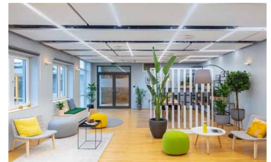
Diese Decke kann beides: Sie erzeugt die richtige Temperatur und absorbiert störenden Schall
